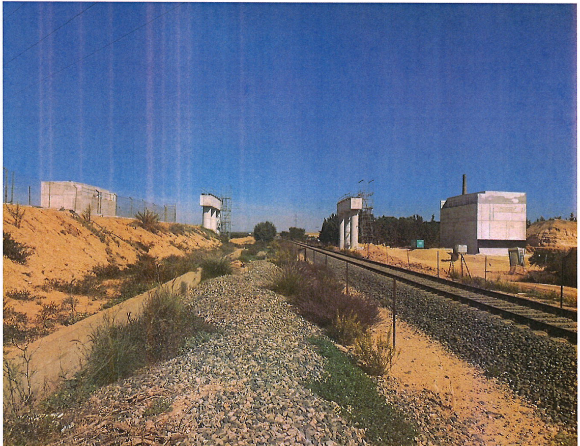
Paso elevado en Santa Ana. (RM-F37)
